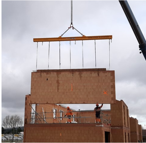
Figure 5 : Levage au palonnier spécifique
