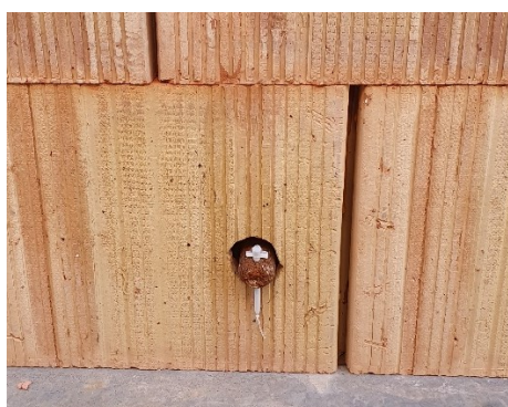
Figure 11 Broche d'ancrage en pied de mur
