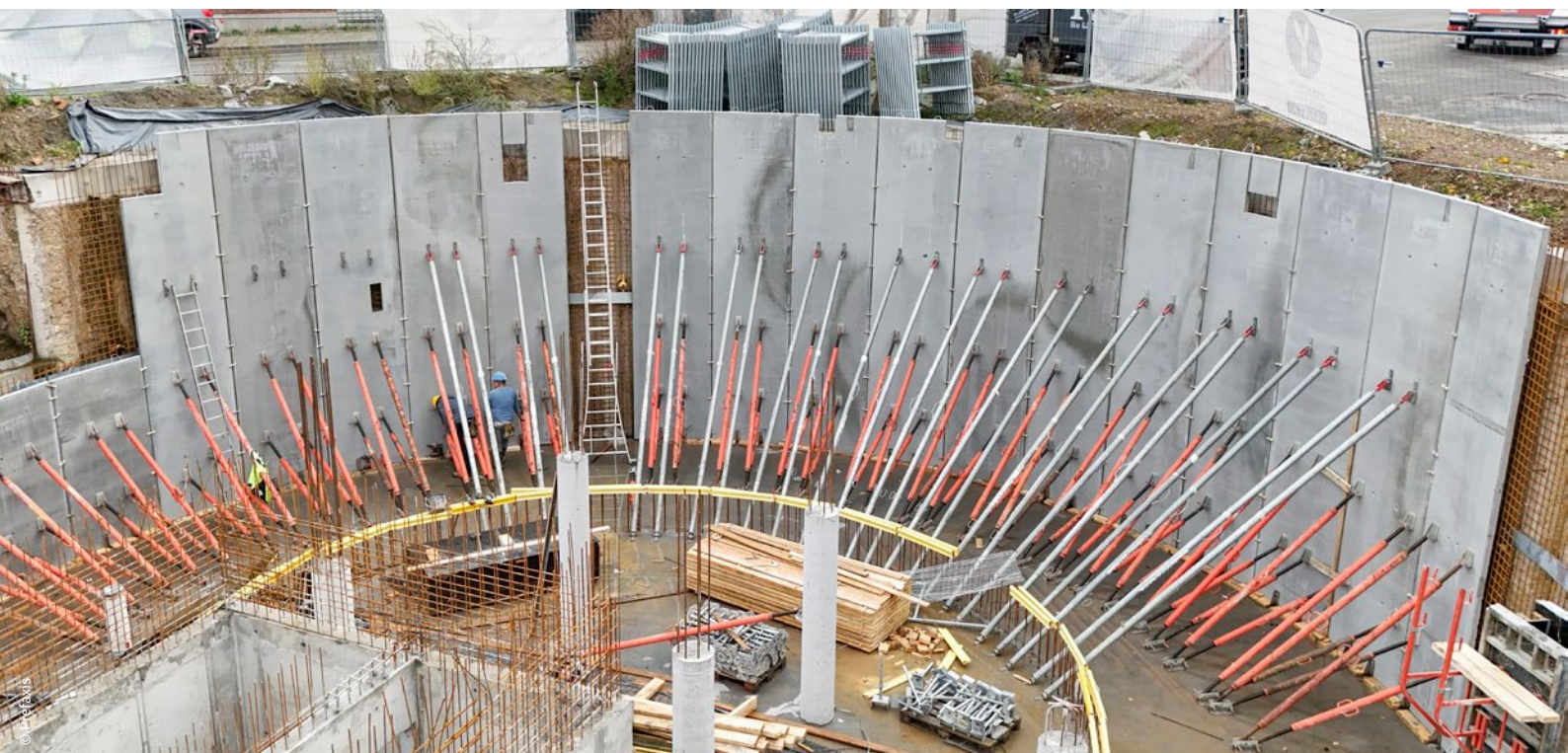
Foto 6 - Druk- en trekschoren bij montage van hoge wandelementen Photo 6 - Des étais tirants-poussants pour le montage d'éléments de mur de grande hauteur
