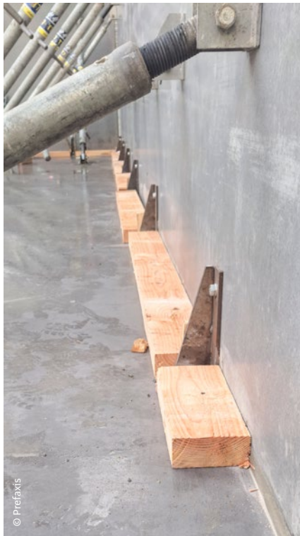
Foto 7 - Houten geleidingsbalken en L-ijzers onderaan de wand Photo 7 - Guides en bois et fers en L au bas du mur
