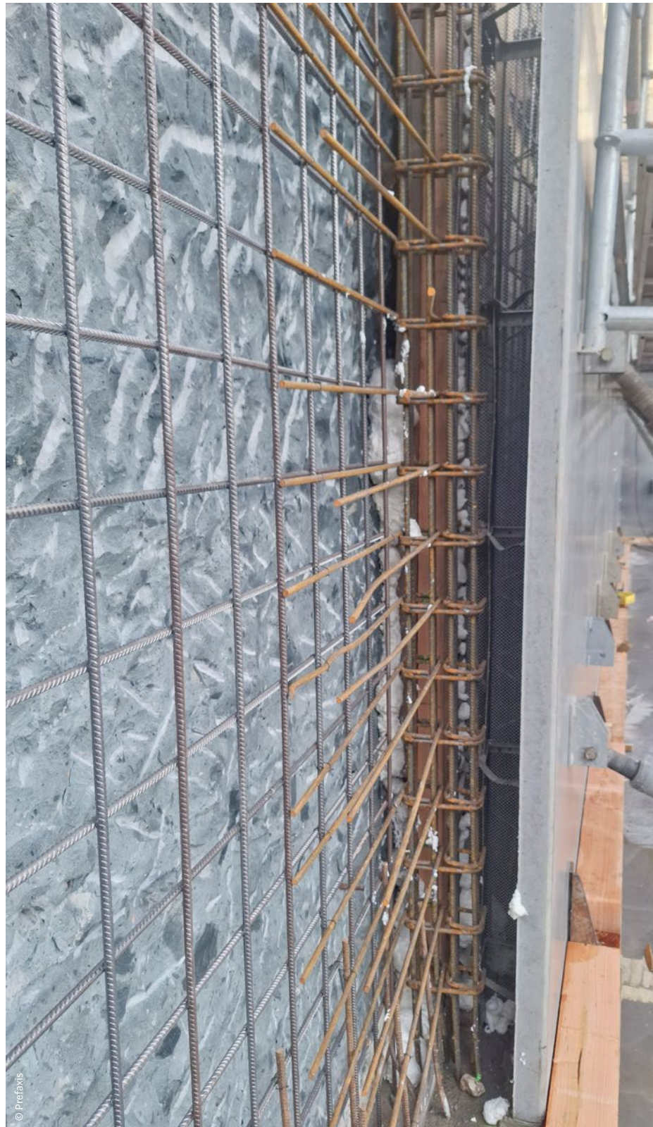
Foto 4 - Bekisting met houten kepers en bouwschuim
