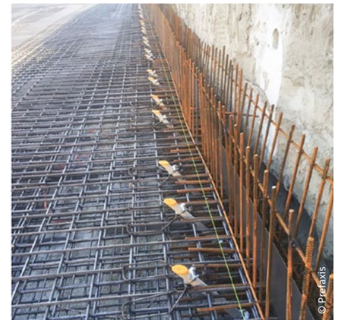
Foto 2 - Ankerhouders voor verankering schoorbokken Photo 2 - Supports d'ancrage pour l'ancrage des tréteaux d'étagage
