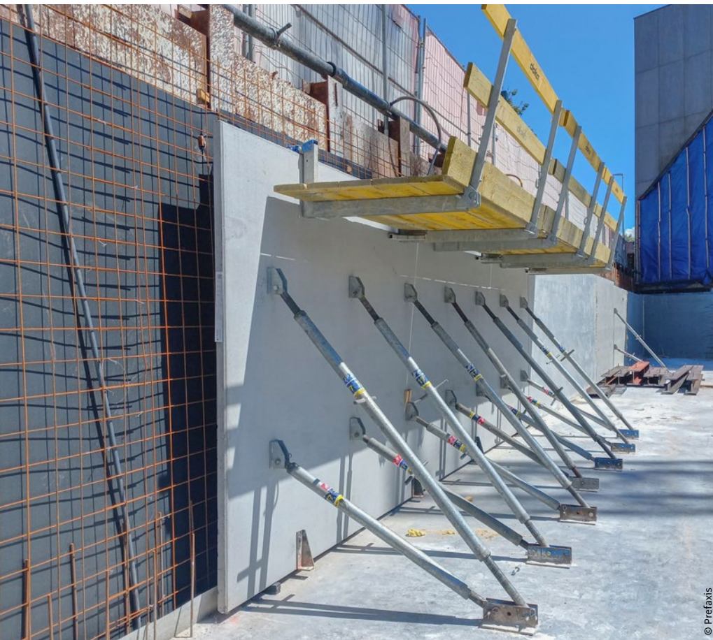
Foto 1 - Prefab oplossing met enkelzijdige wandelementen Photo 1 - Solution préfabriquée avec des éléments mono-paroi
