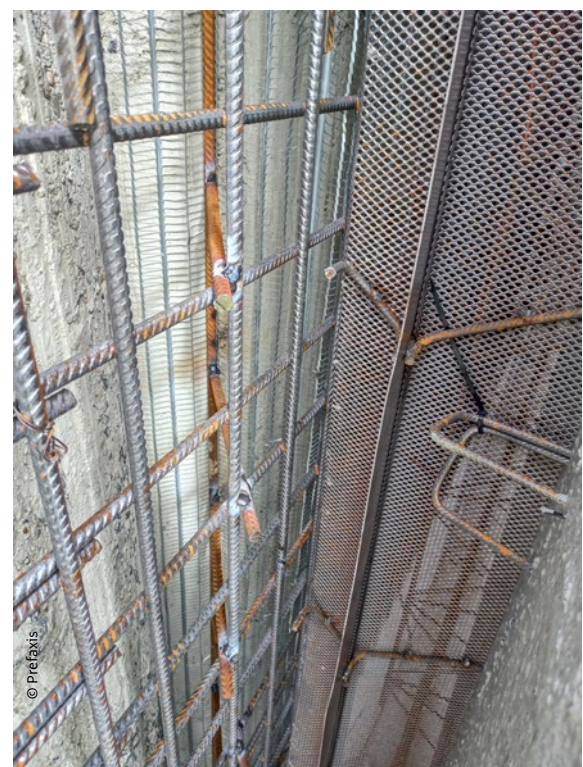
Foto 5 - Bekisting met stremstaal Photo 5 - Coffrage avec des arrêts de bétonnage
